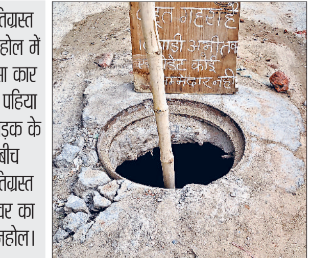
क्षतिग्रस्त मैनहोल में फंसा कार का पहिया व सड़क के बीच क्षतिग्रस्त सीवर का मैनहोल।
